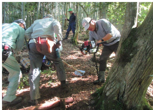
階段：縦の杭穴ドリルにて
