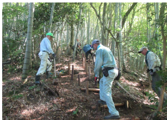
階段：縦杭設置
