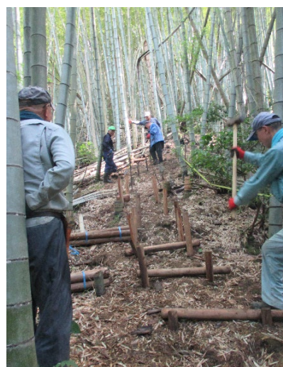
階段：縦杭設置 (大ハンマーにて)
